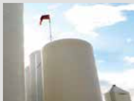
MONITOR DE DEPÓSITO
